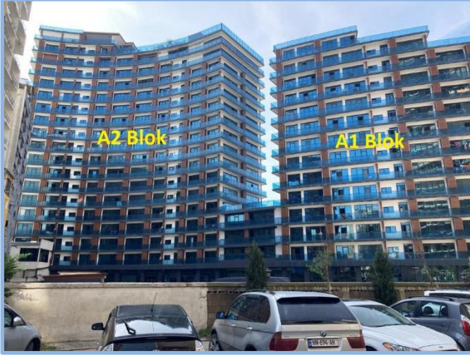
Taşınmazların Bulunduğu A1-A2 Blok (arka cephe)
