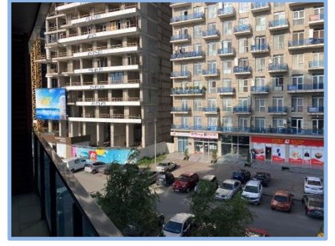
A1 Blok A202 No'lu Daire
